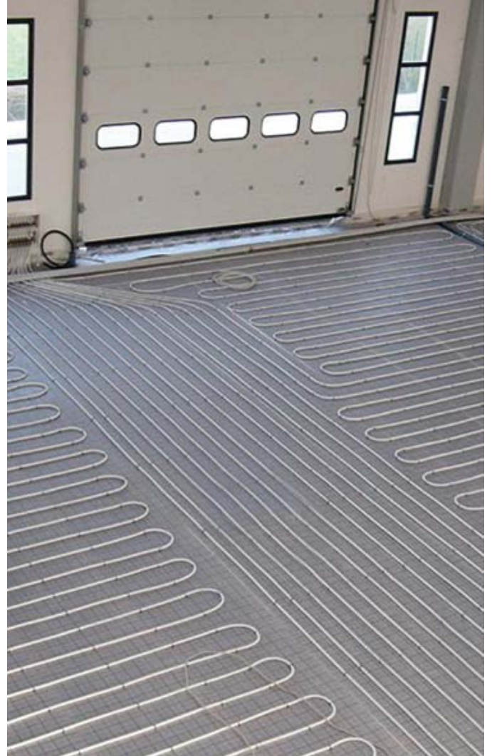
Capannone - Sondrio (Italia)
