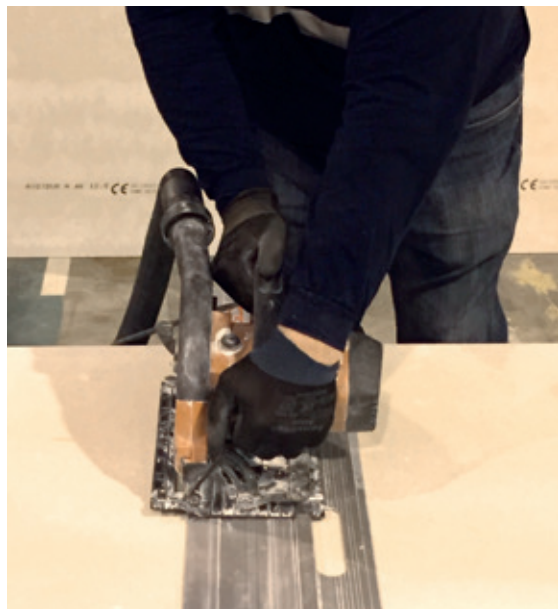
Taglio lastre in gesso fibrato con sega circolare
