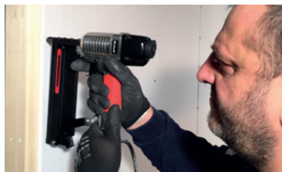
Avvitatura/Graffatura su struttura in legno
