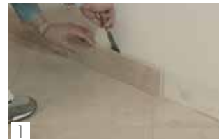
1 Eliminare il battiscopa Remove skirting
