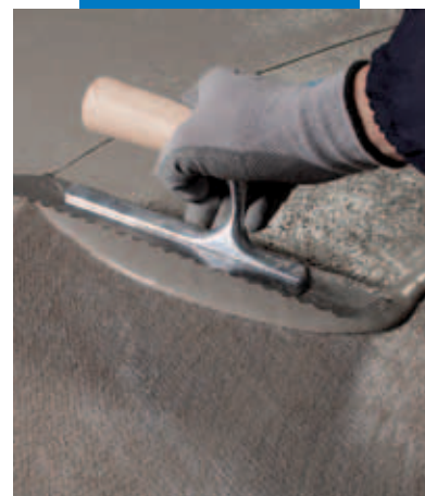
Seconda mano di Mapelastic Turbo su prima armata con Mapetex Sel
