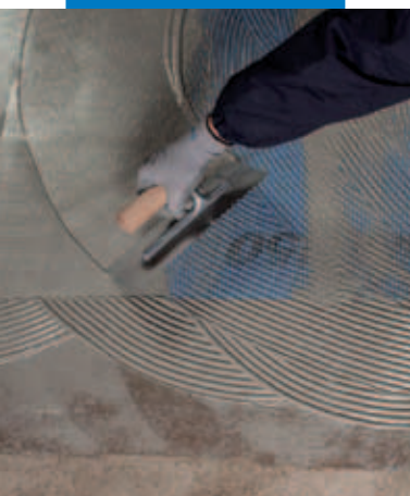
Inserimento di Mapenet 150 nella prima mano di Mapelast Turbo fresca
