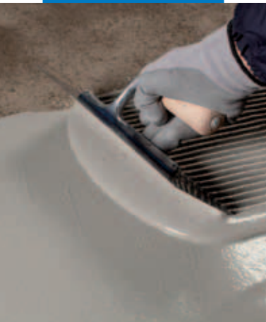
Applicazione della prima mano di Mapelast Turbo
