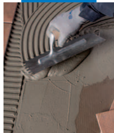
Posa di piastrelle con Elastorapid
