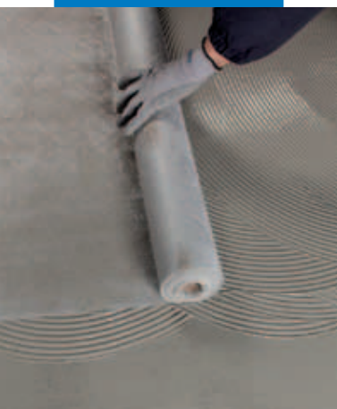
Inserimento di Mapetex Sel nella prima mano di Mapelast Turbo fresca
