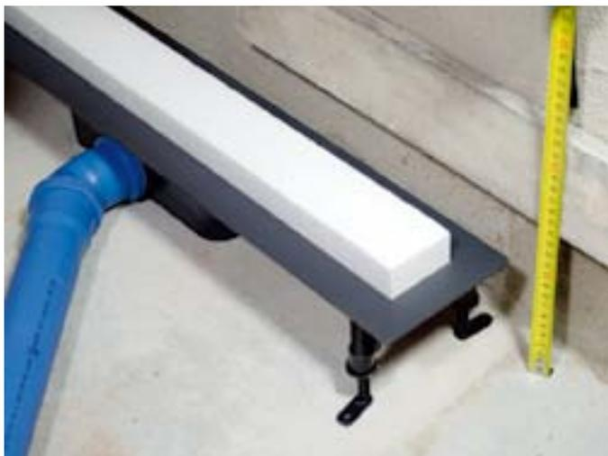
Dopo aver fissato al corpo sifone i supporti per la regolazione dell'altezza, collegare il tubo di scarico (diametro 50 mm) e regolare l'altezza dei piedini per raggiungere l'altezza desiderata.
