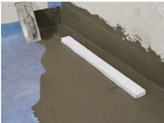
Procedere all'impermeabilizzazione del pavimento e delle pareti.
